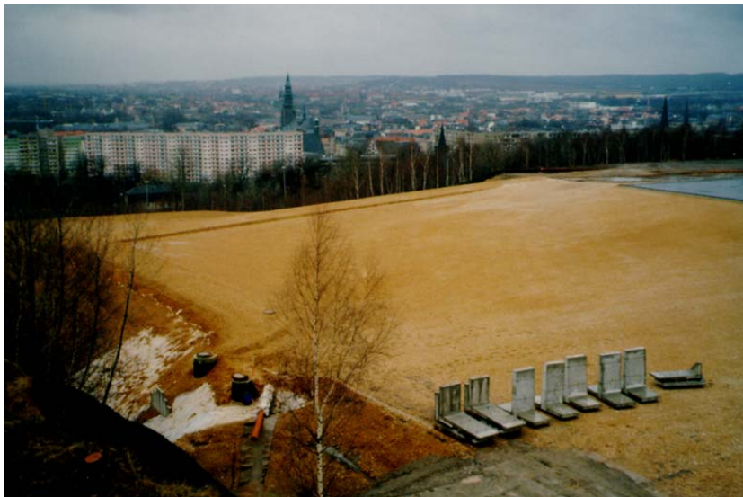
Fertiggestellte Oberfläche zur Bebauung vorgesehen
